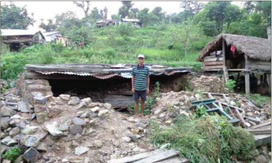
Huiseigenaar voor zijn ingestorte woning
