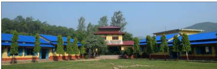
De Kumarischool met nieuw dak
