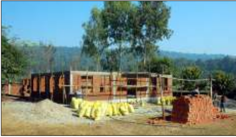
De keuken-eetzaal in aanbouw
