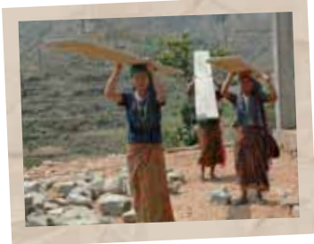
De bewoners van Bobok hielpen mee met de bouw van de nieuwe school
